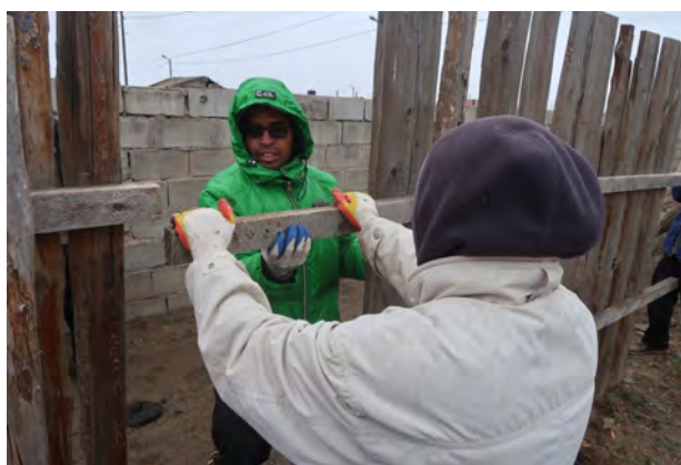
Pomoc s opravou plotu.
