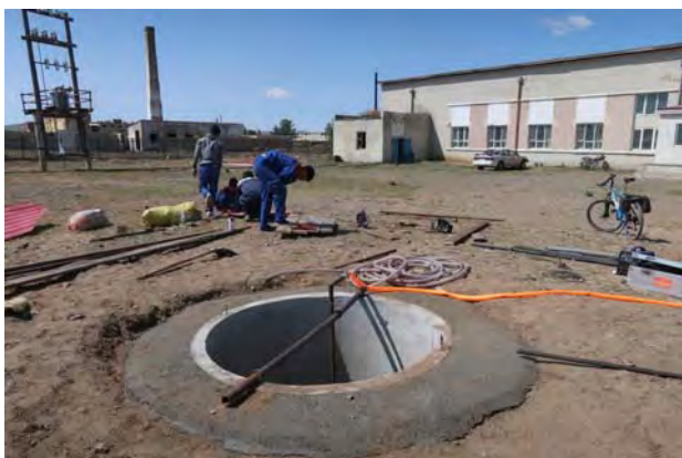
Studenti z technické školy Don Bosco opravují studnu v Shuwuu.
