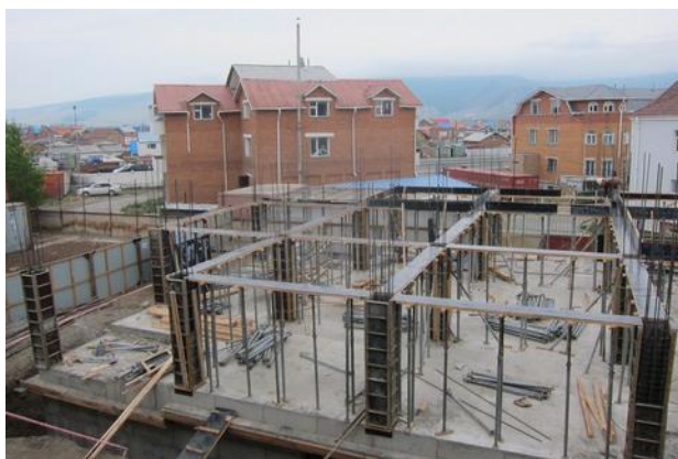
Stavba nového salesiánského domu pro děti ulice v Ulánbátaru.
